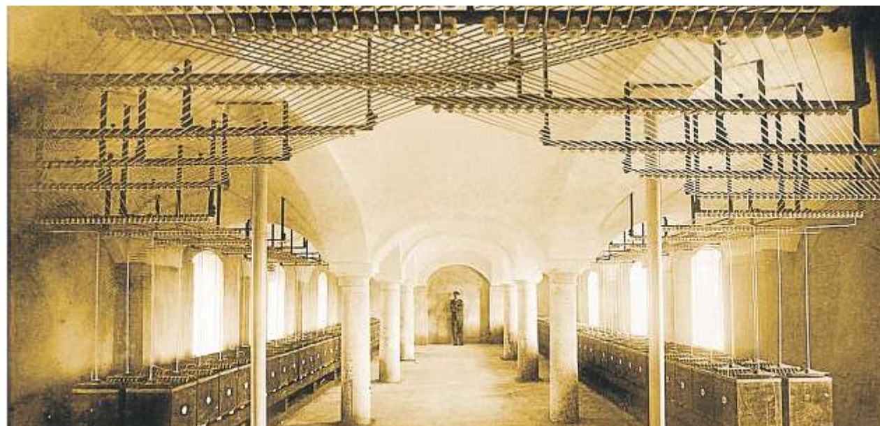
Innenansicht des ehemaligen E-Werks
